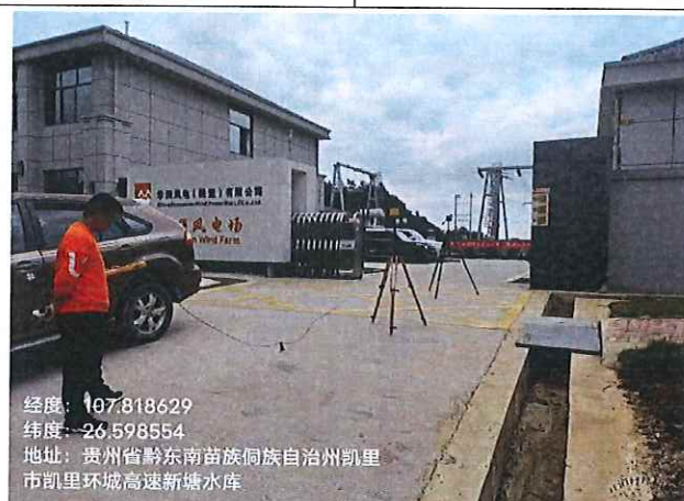
东顺风电场 110kV 升压站西南侧围墙升压站门口
