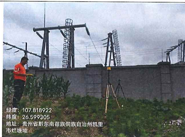
东顺风电场 110kV 升压站东北侧围墙
