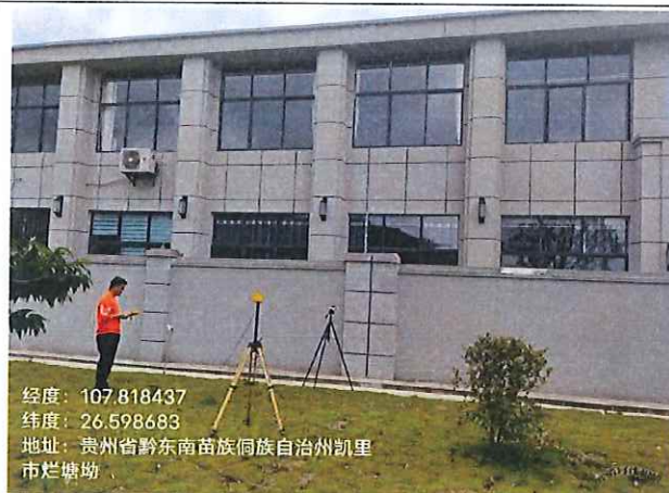
东顺风电场 110kV 升压站西南侧围墙
