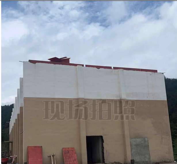
项目购买的现有建筑
