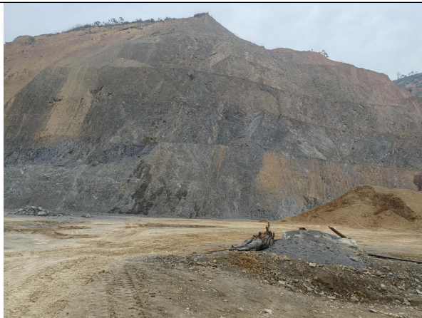
矿区东侧现状
