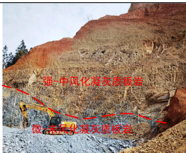
照片1 强-中风化与微-未风化 凝灰质板岩界线
