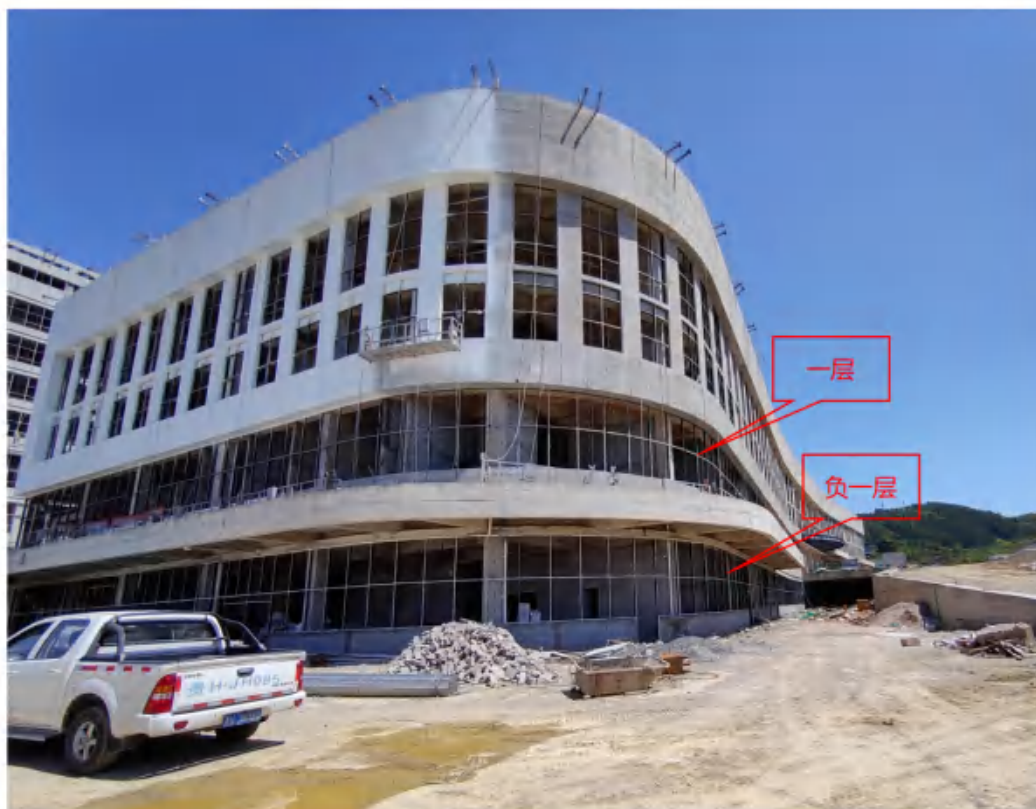
图 1-1 门诊医技楼建设现状（DSA 位于负一层）
