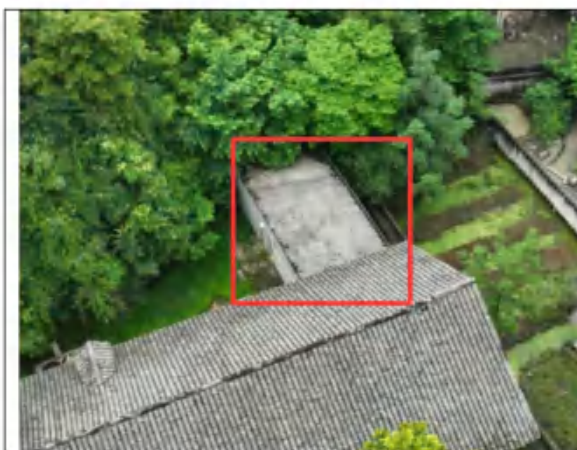
拟拆除厕所现状
