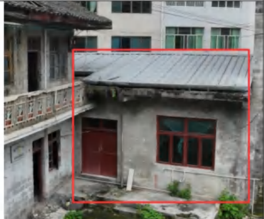
拟拆除厨房现状
