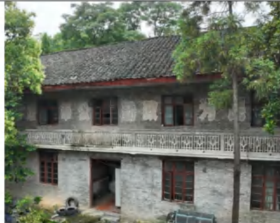
拟拆除危房 3 现状
