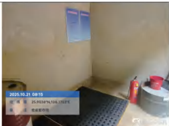
主体探矿工程建设的危废暂存间
