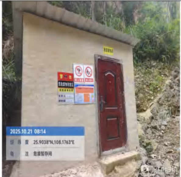
主体探矿工程建设的危废暂存间
