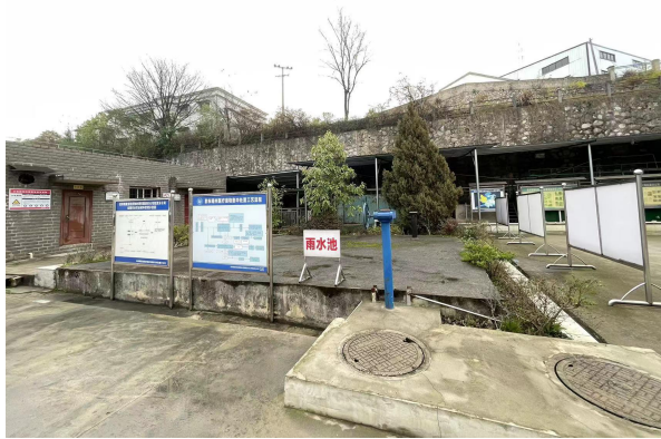
现有 1#雨水收集池
