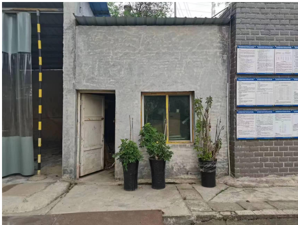
闲置建筑（拟改造成新医疗废物暂存间）
