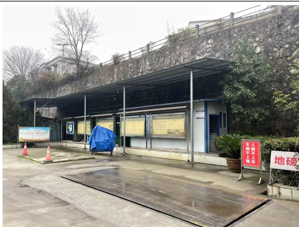
现有厂区污水处理站
