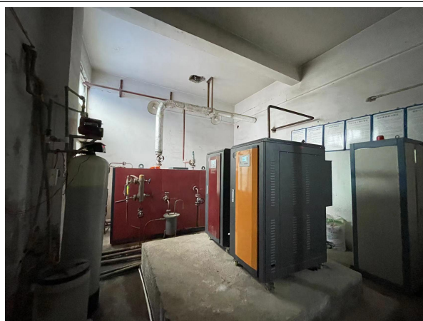
现有厂区锅炉房
