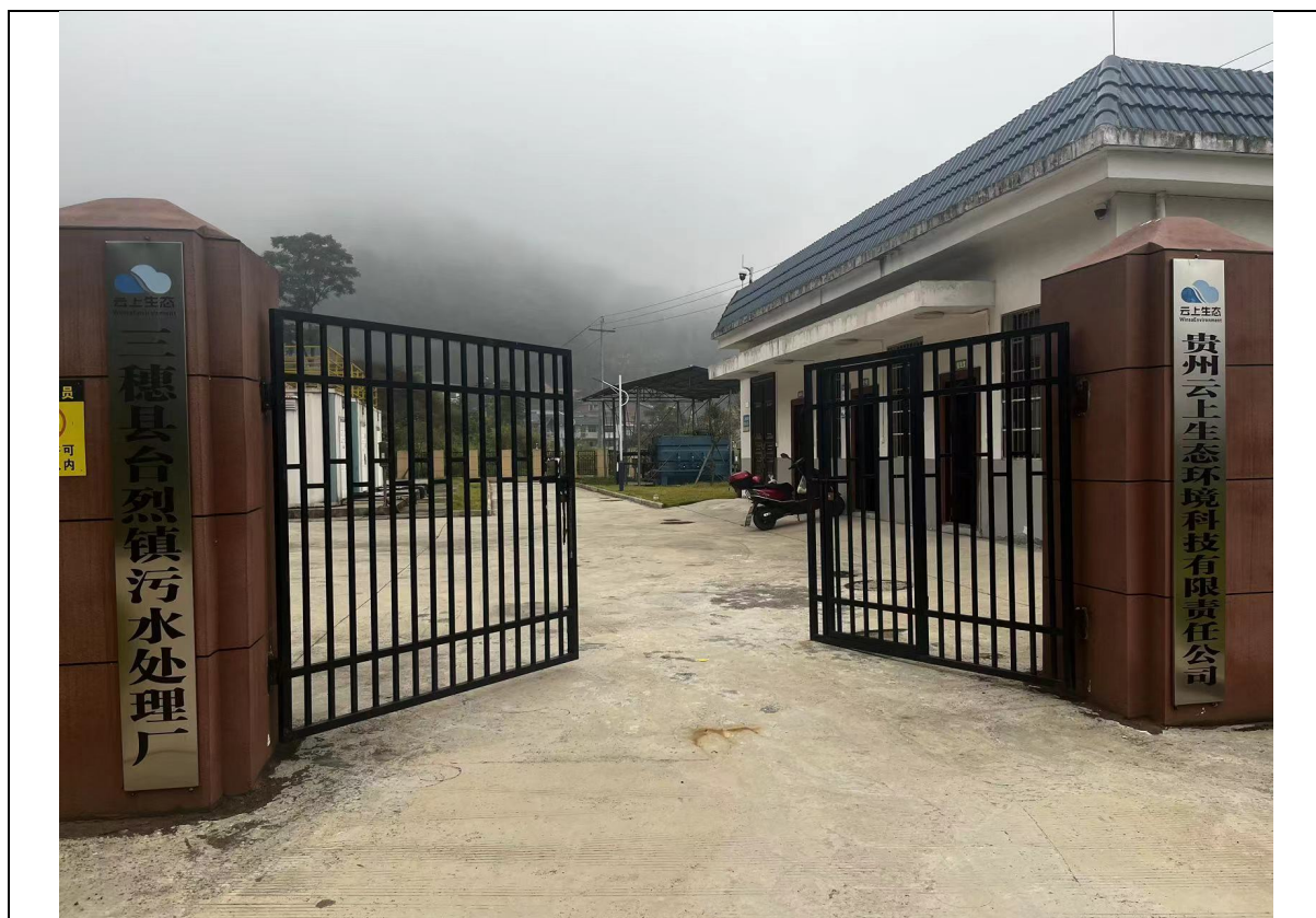
厂区入口现状图
