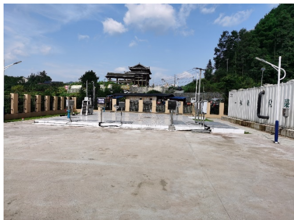
预处理组合池现场照片
