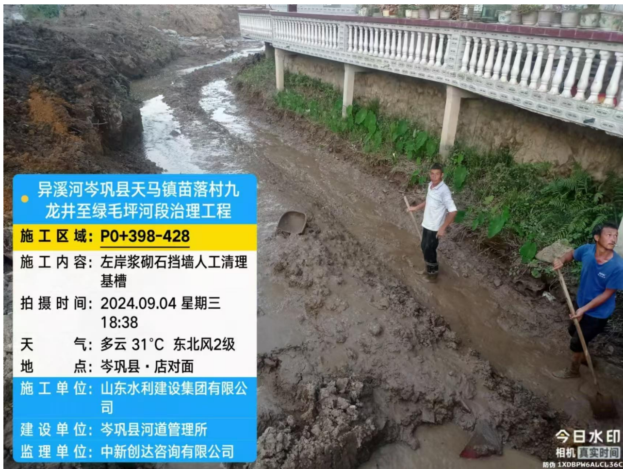
工人清理基槽照片
