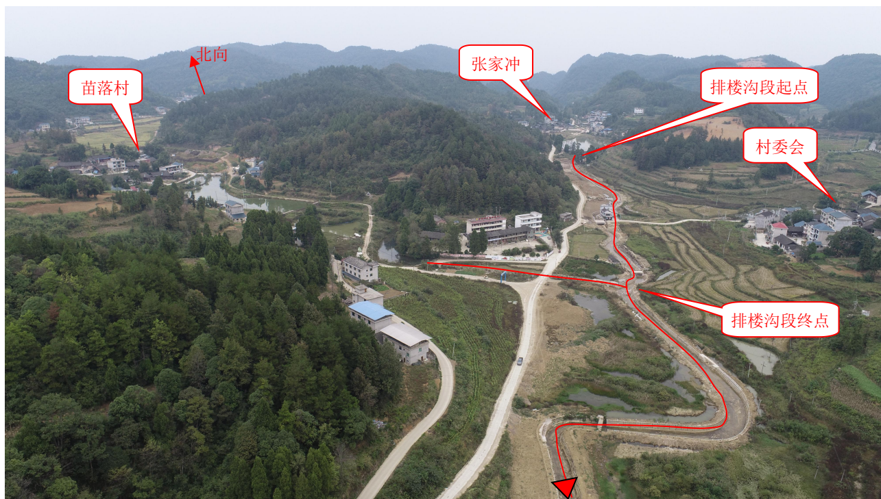
P0+000~P0+595、YA2+523~YA2+772 排楼沟段和异溪河主干段现状
