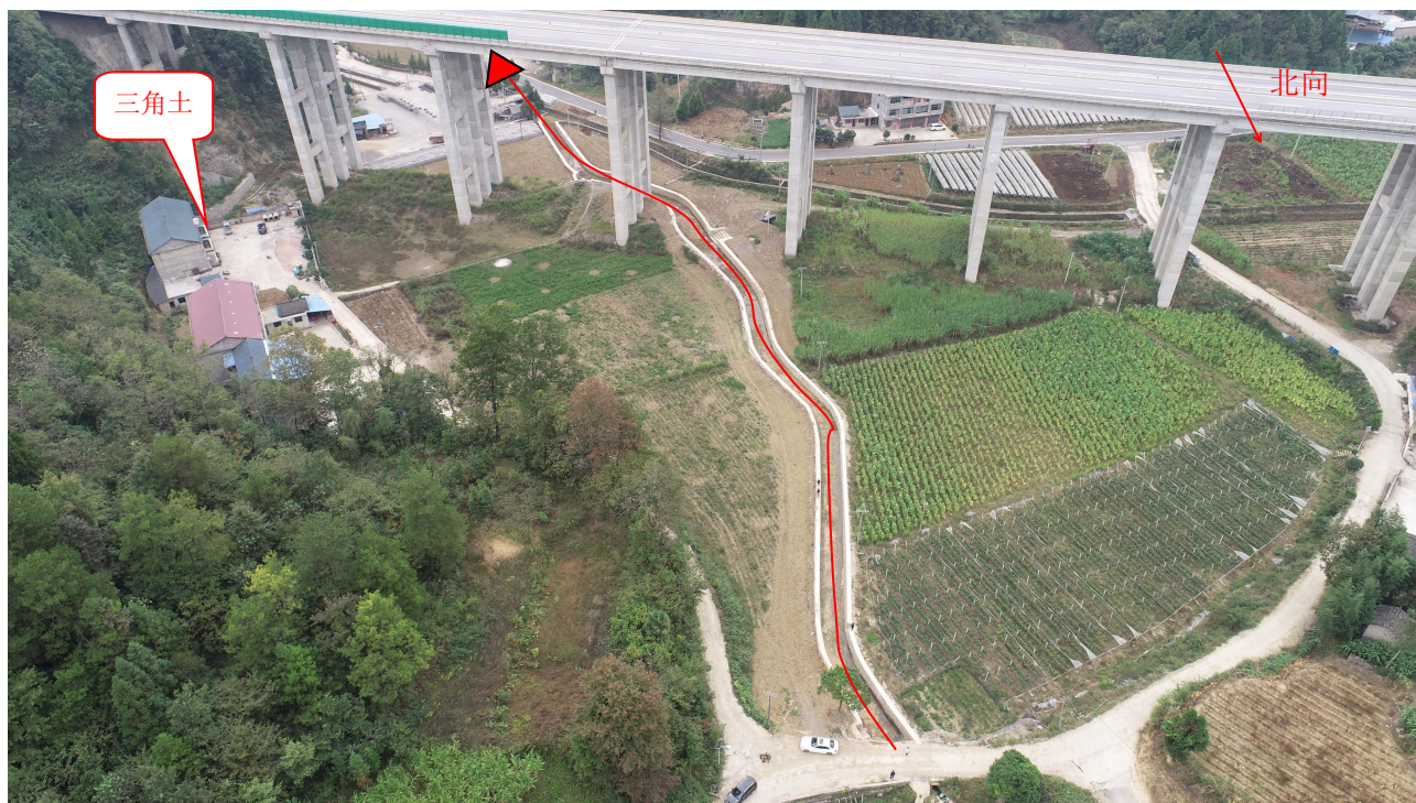
L0+000~L0+156 烂桥沟段起点现状
