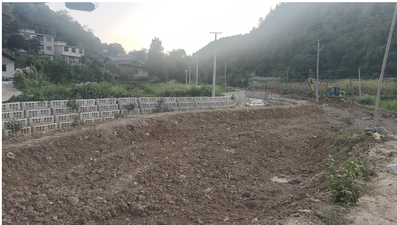
现场施工照片
