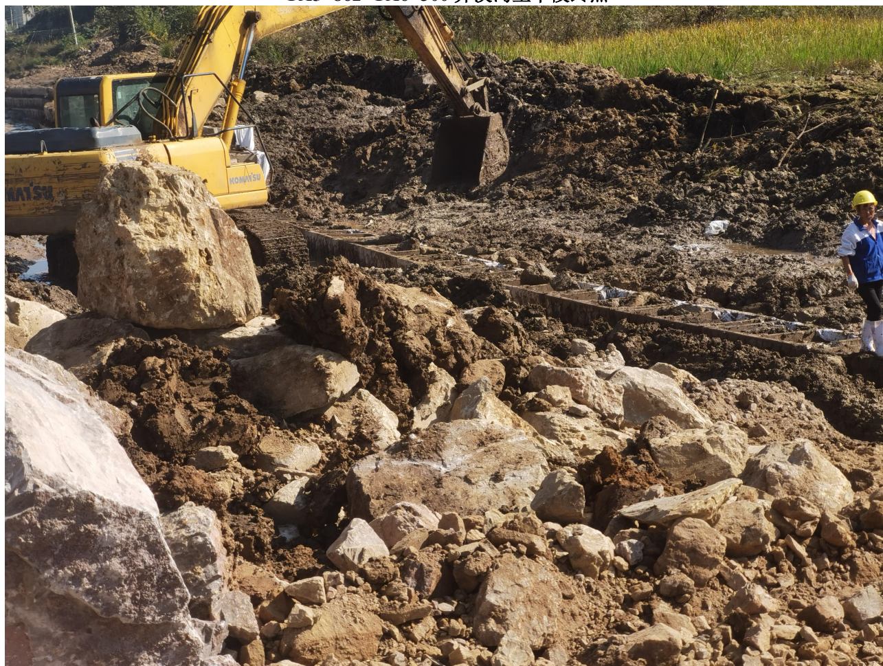
项目施工现场照片
