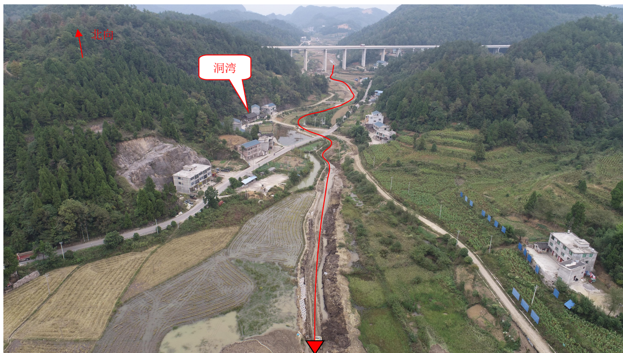
YA2+523~YA4+500 异溪河主干段现状
