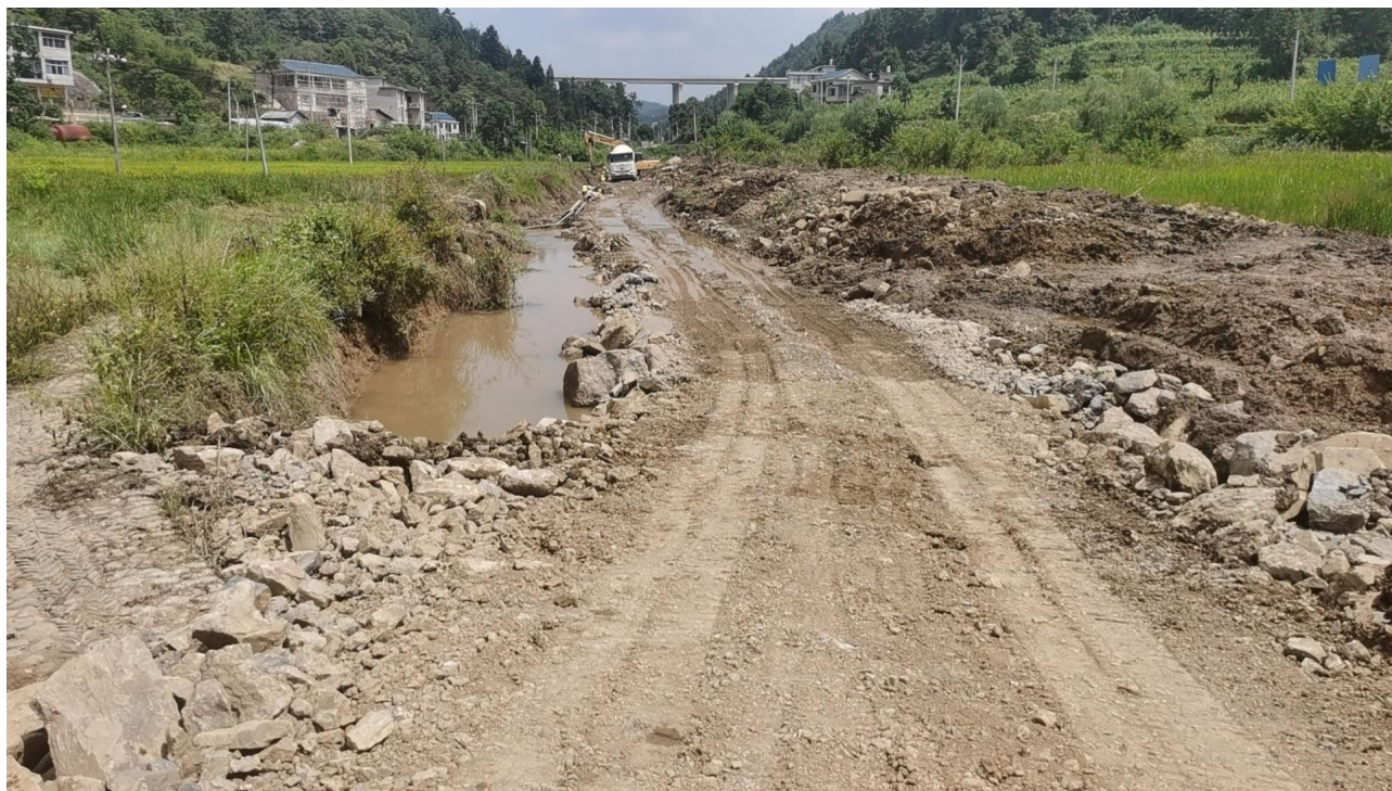
现场施工现状
