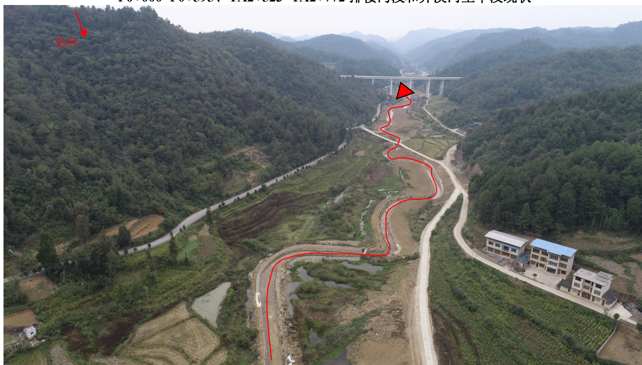
YA2+800~YA3+600 异溪河主干段现状
