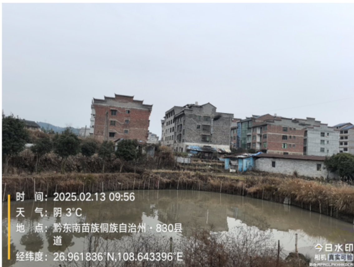
项目地现状及项目东北侧
