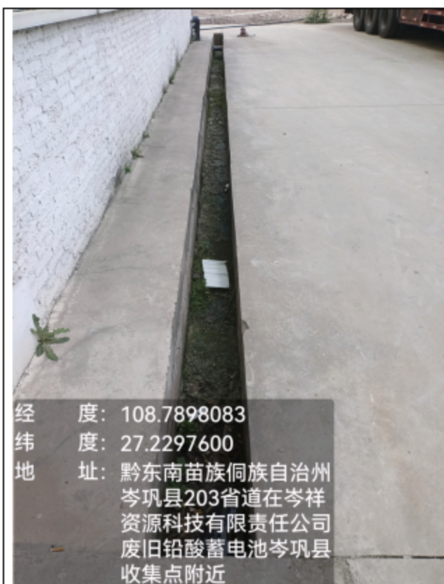
项目厂房周边雨水排水沟
